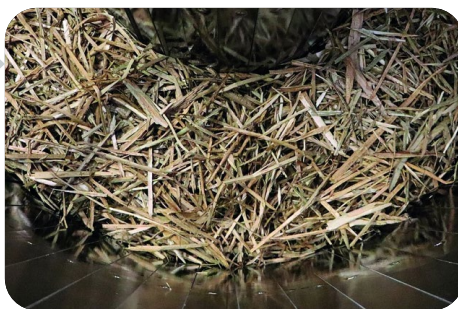
Gleichmäßig befüllte Schalung
