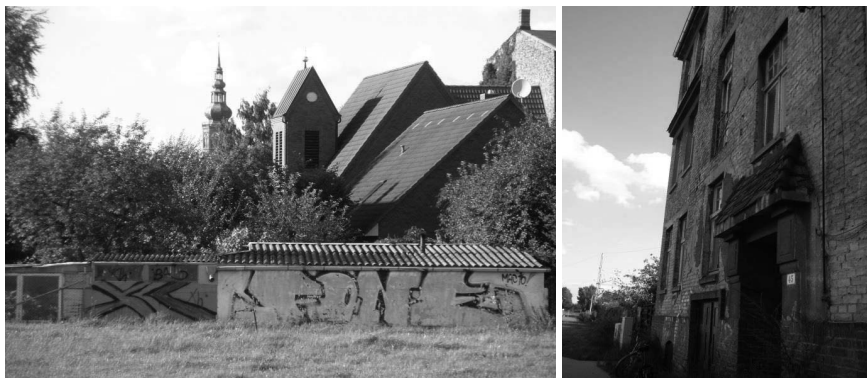
Graffiti und Anzeichen baulichen Verfalls in der Gützkower Straße in Greifswald, eigene Aufnahmen der Verfasserin vom 19.8.2010.
